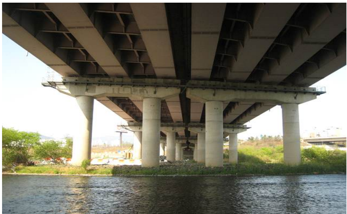
하부구조 전경 - 교각(P6)
