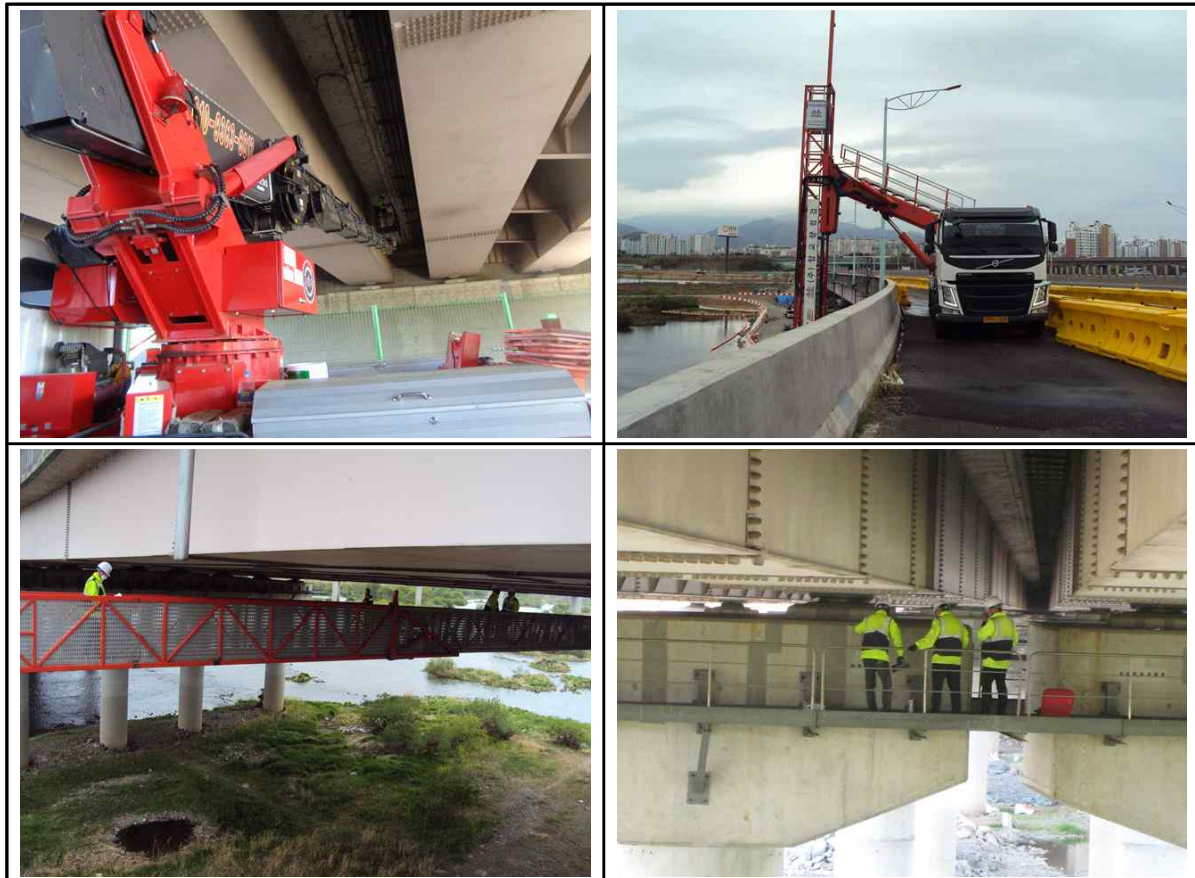
<그림 3.2> 고소작업차, 교량점검차, 도보점검 등을 이용한 외관조사
