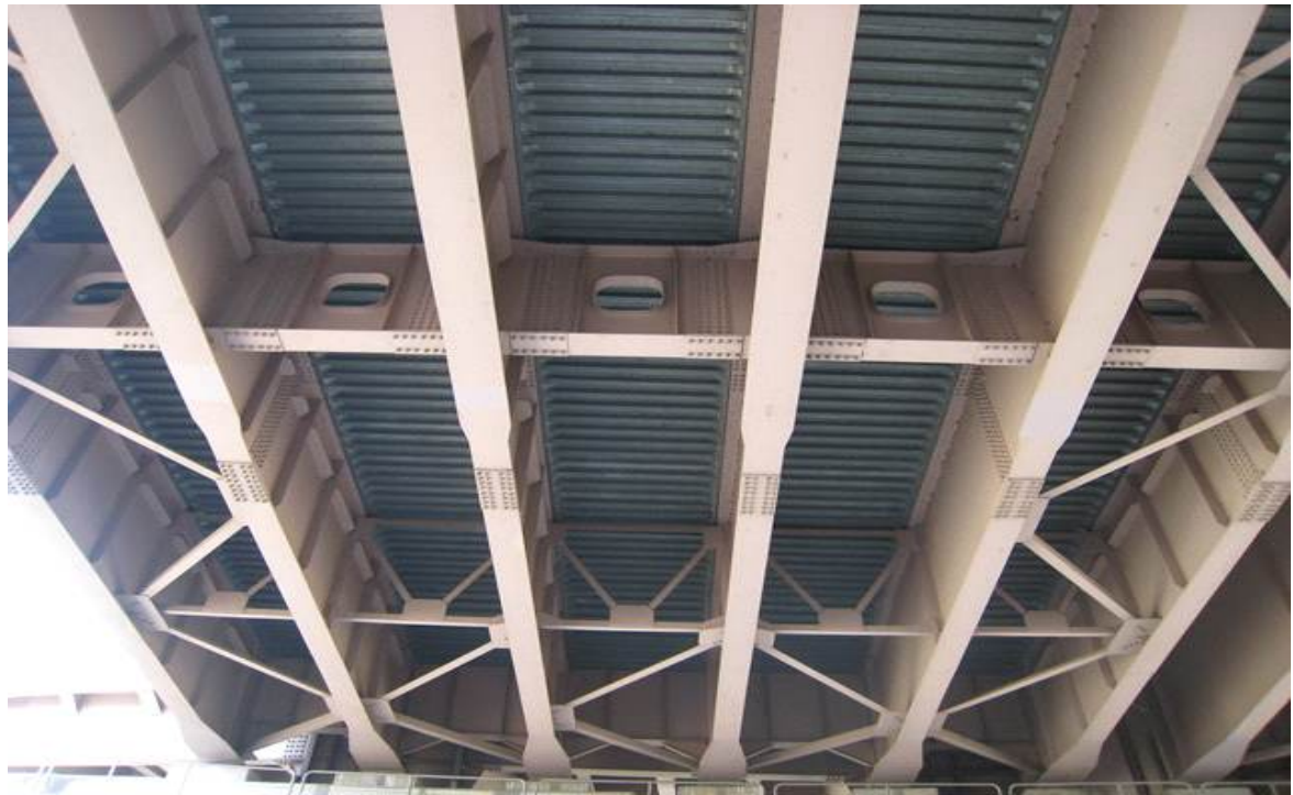
상부구조 전경 - 외부(SPG-S1)
