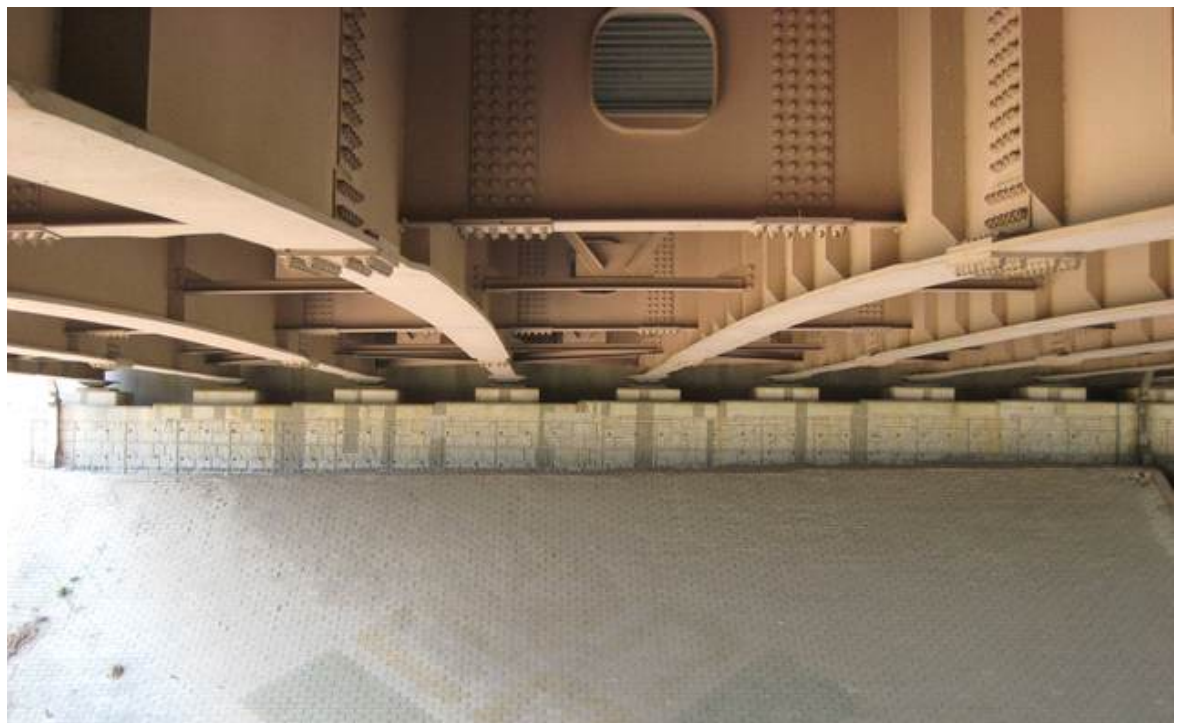
하부구조 전경 - 교대
