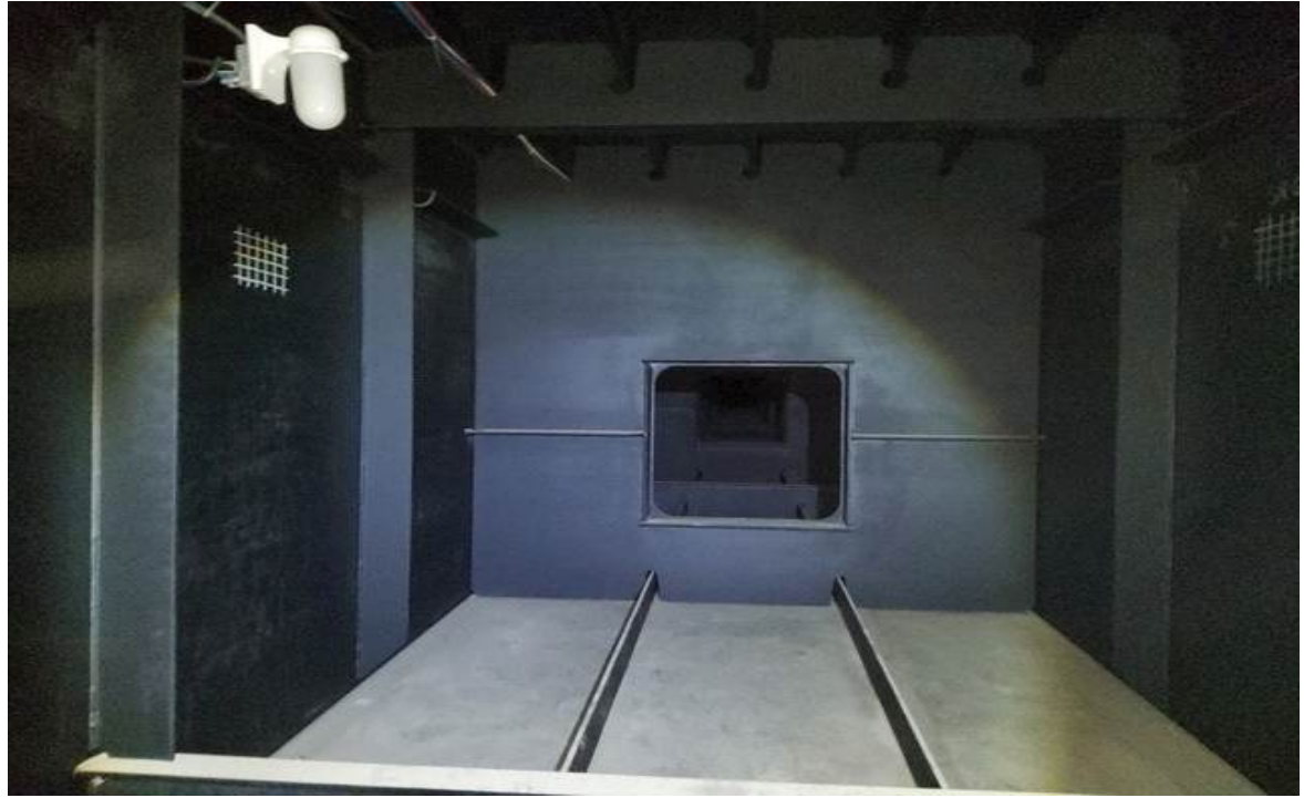
상부구조 전경 - 내부
